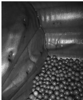
图 3: 磨机衬板磨损情况——使用 6 个月的锰钢衬板
